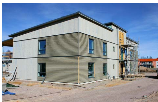
Tvåvåningshusen färdigställs under sommaren 2014.
