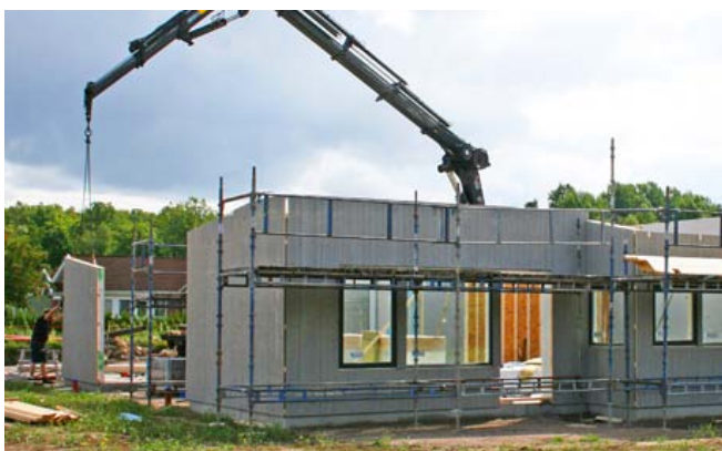
I augusti var grunderna klara och väggarna kom på plats.
