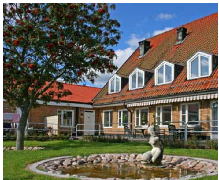
Prästgårdsvägen 2 E-L / Storgatan (Västanå), Ryssby. 2-våningshus fördelat på 10 lägenheter.
