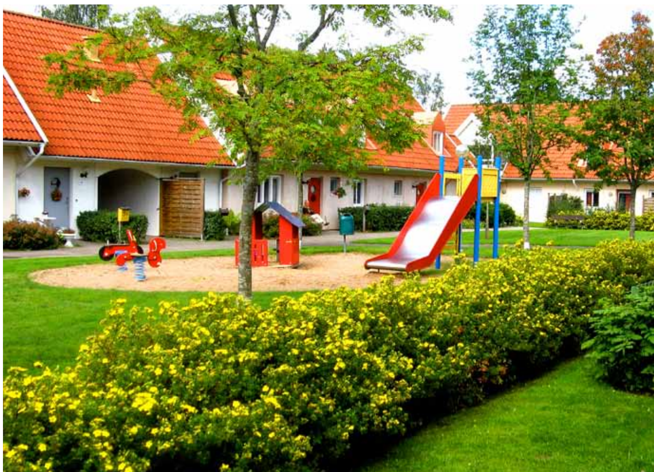
Parkgatan/Norra Järnväggsgatan - Kvarteret Herkules. Beläget centralt, nära bibliotek och hembygdspark. 42 marklägenheter.
